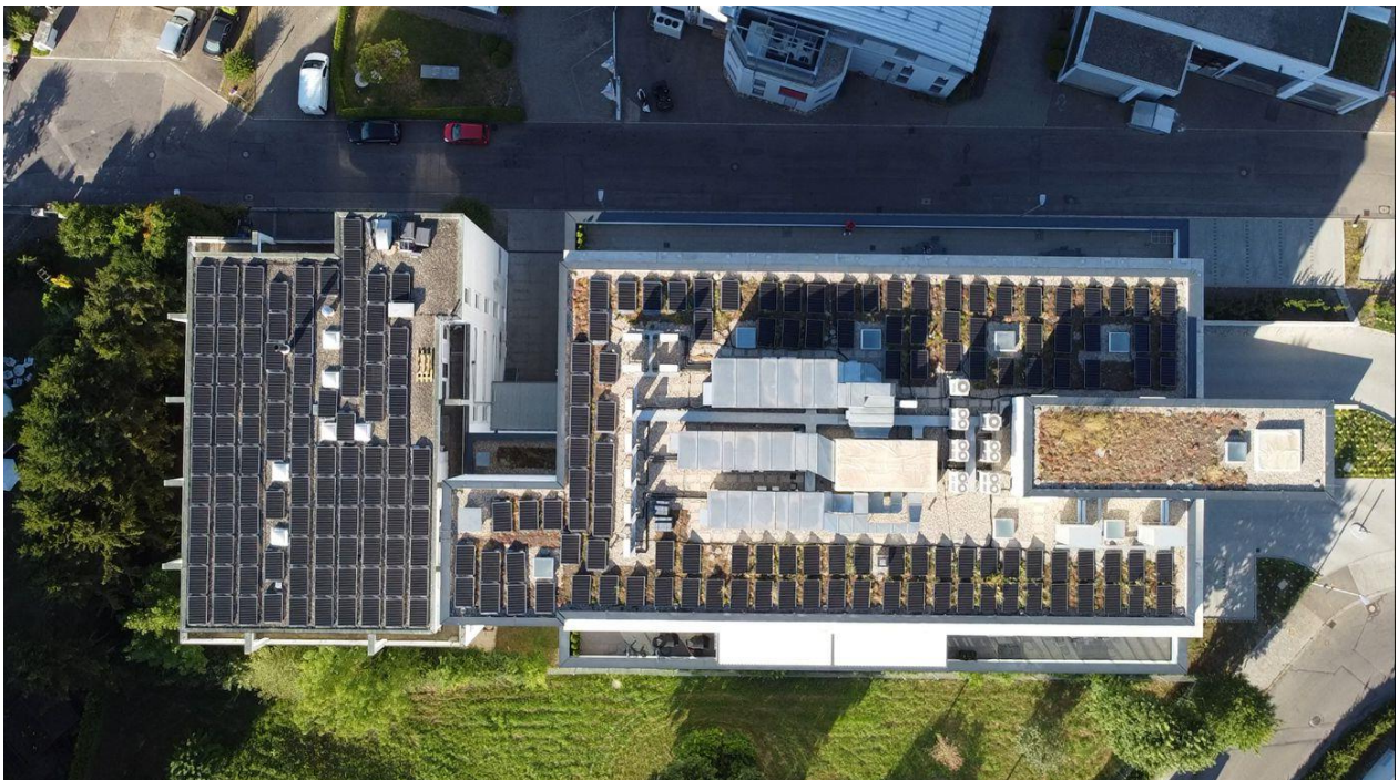
Abbildung: Bestandsgebäude (rechts) und Neubau (links), mit PV-Solaranlagen auf dem Flachdach.
