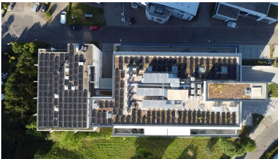
Abbildung: Bestandsgebäude und Neubau, mit PV-Solaranlagen auf dem Flachdach (Stand 2023)
